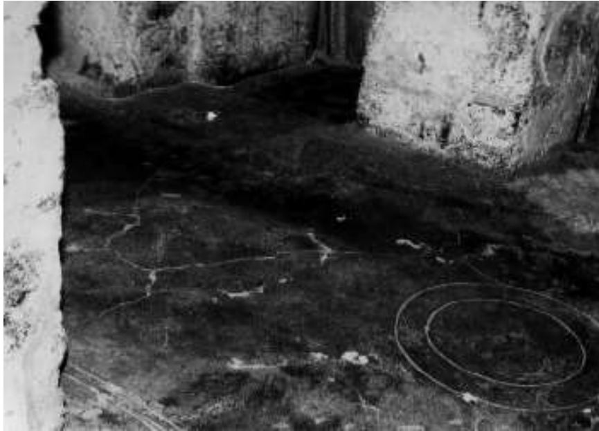
Το τσιμεντένιο δάπεδο εσωτερικά
