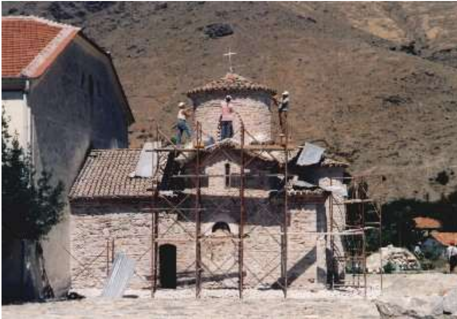
Νότια όψη. Καθαίρεση επιχρισμάτων και αρμολόγηση
