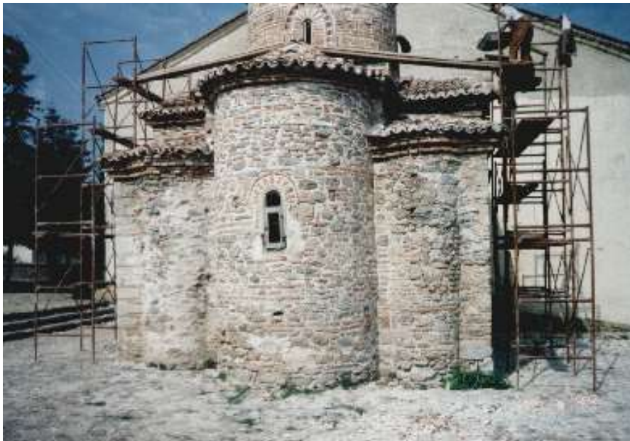
Ανατολική και ΝΑ όψη. Καθαίρεση επιχρισμάτων και αρμολόγηση
