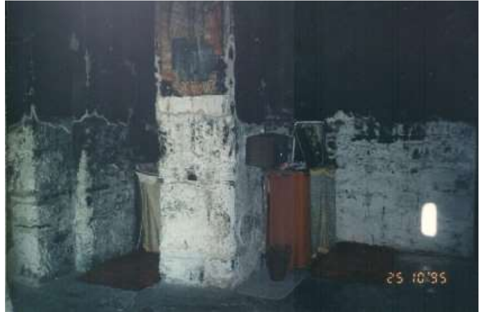
Κατεστραμμένες τοιχογραφίες στα χαμηλότερα τμήματα του ναού
