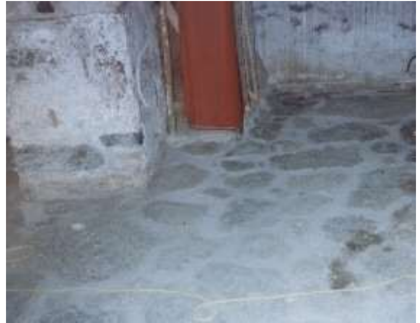
Συντήρηση – συμπλήρωση δαπέδου
