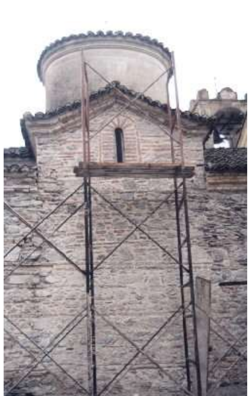
Βόρεια όψη. Καθαίρεση επιχρισμάτων και αρμολόγηση
