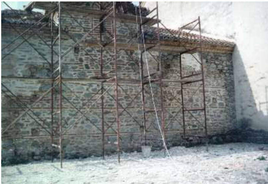
Βόρεια όψη. Καθαίρεση επιχρισμάτων και αρμολόγηση
