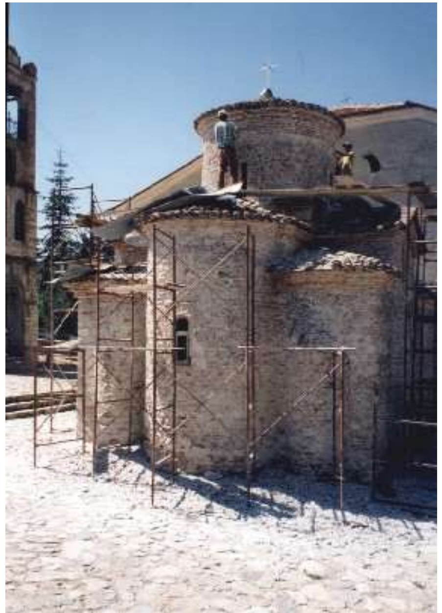
Ανατολική και ΝΑ όψη. Καθαίρεση επιχρισμάτων και αρμολόγηση
