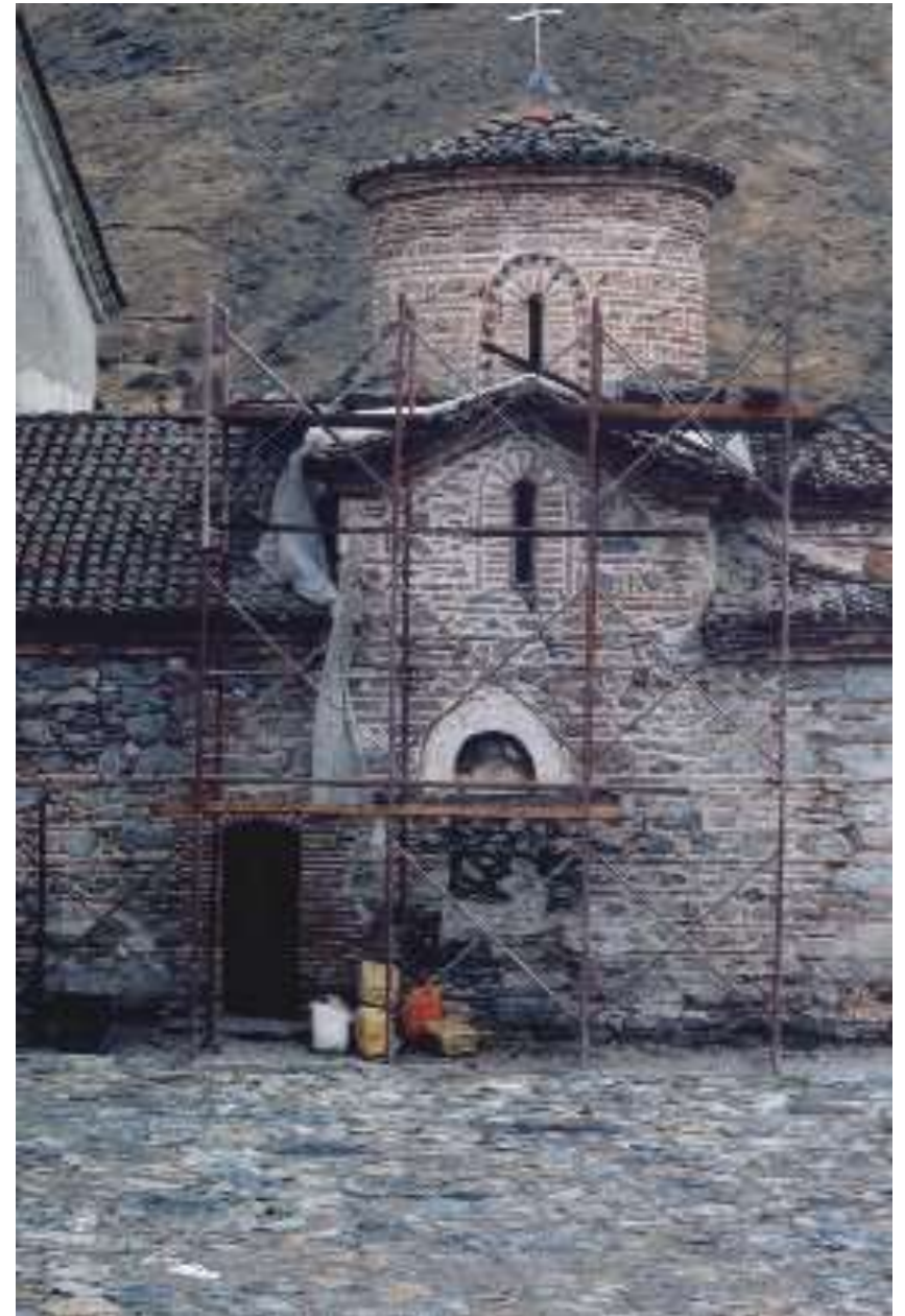
Νότια όψη. Καθαίρεση επιχρισμάτων και αρμολόγηση
