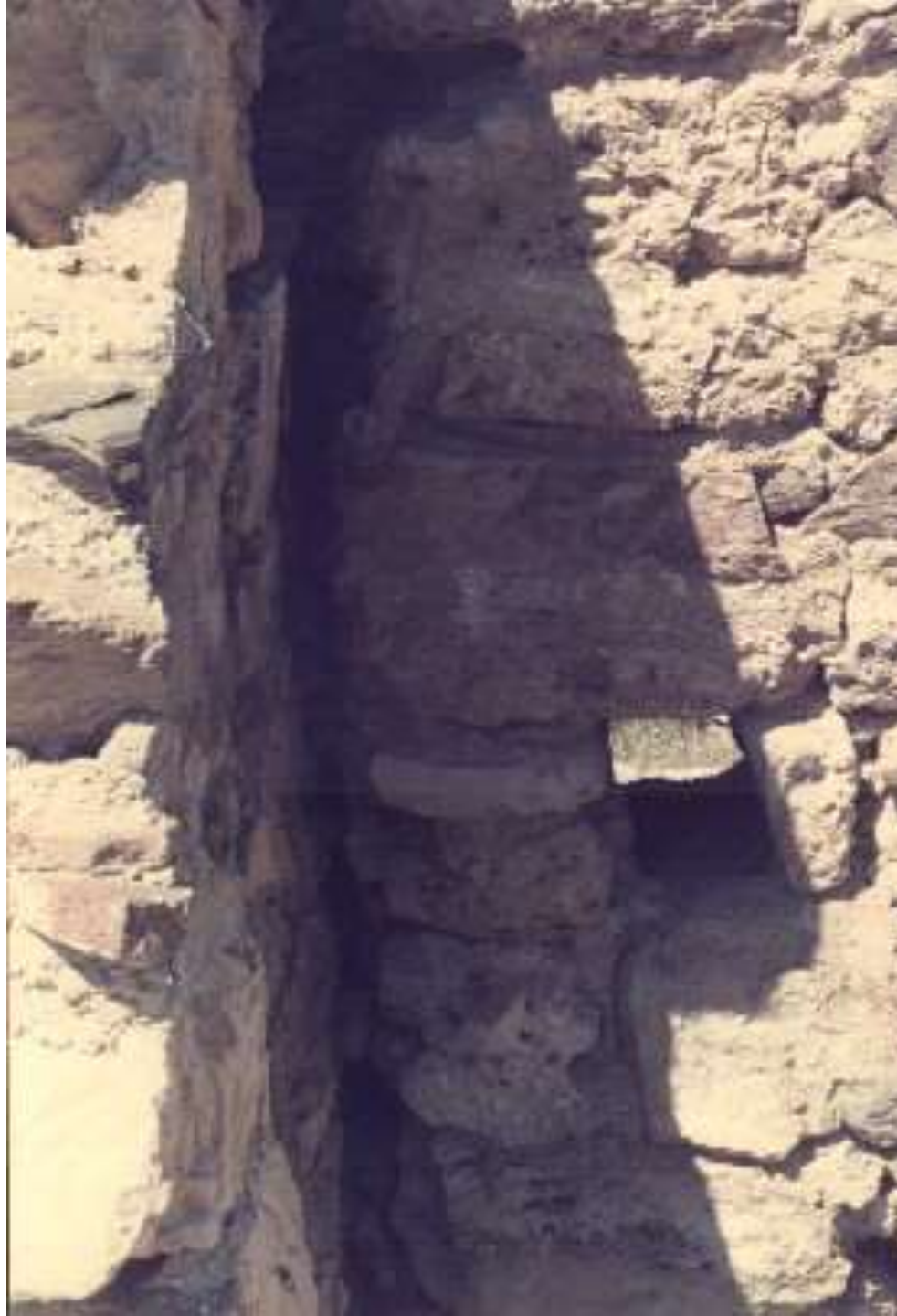
Αρμός στην ένωση τοιχοποιιών
