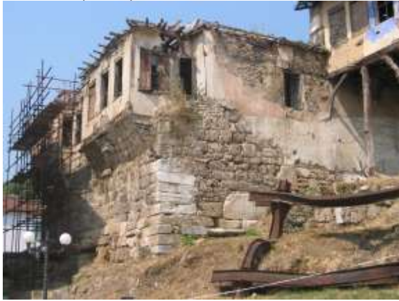
Εικ. 5 Κατοικία επί του πύργου. ΝΑ γωνία
