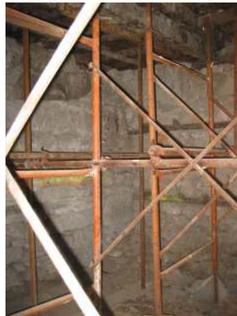
Εικ. 14 Η γωνία που συναντά ο διάμεσος τοίχος (αριστερά) το νότιο. Διακρίνονται οι ξυλοδεσιές που σταματούν στη γωνία. Η παρειά αυτή του διάμεσου τοίχου συνεχίζεται μέχρι την εξωτερική όψη.
