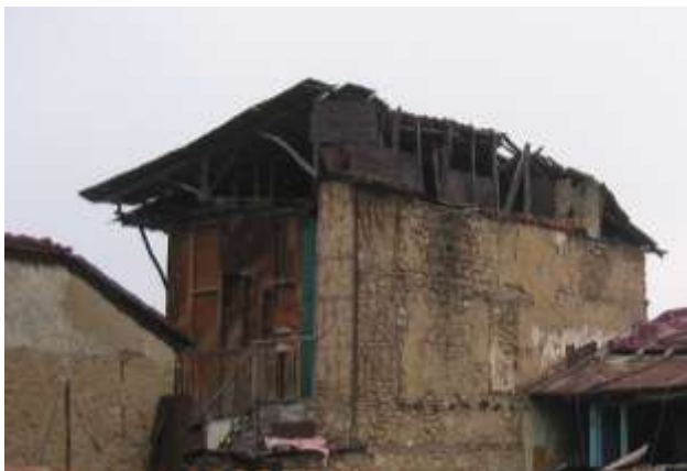
Εικ. 19 ΝΑ κτήριο. Η κομμένη στέγη που οδηγεί στο συμπέρασμα ότι το κτήριο εκτεινόταν δυτικά και βόρεια. Διακρίνεται η φραγμένη πόρτα και τα επιχρίσματα στην τυφλή σήμερα όψη.
