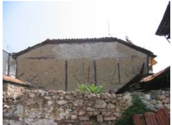
Εικ. 8 Το τρίτο κτήριο του συγκροτήματος. Δυτική όψη
