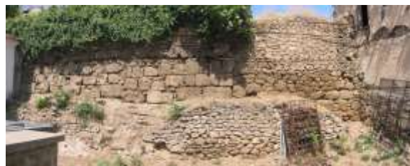
Εικ. 2. Τμήμα του διαμέσου τείχους, δυτικά του συνόλου
