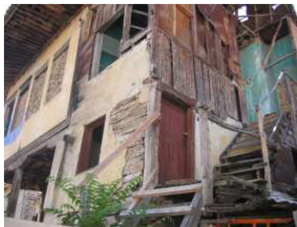
Εικ. 22 ΝΑ κτήριο. Λεπτομέρειες από τα ενσωματωμένα υποστυλώματα και η σκάλα ανόδου
