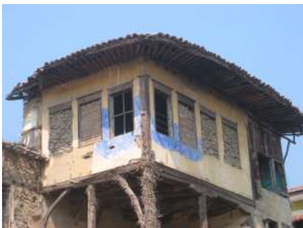
Εικ. 21 ΝΑ κτήριο. Δια κρίνεται η ένωση των υποστυλωμάτων με το ξύλινο δοκάρι.
